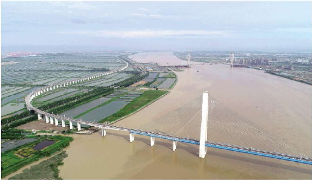
南沙港铁路的跨江铁路桥（六月十六日摄）。（图片来源：新华社记者卢汉欣摄）
